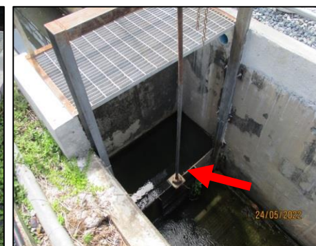
รูปที่ 13 ประตูกั้นน้ำมัน (Oil trap gate) และระบบป้องกัน น้ำท่วม ในกรณีฉุกเฉิน
