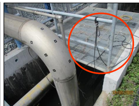
รูปที่ 13 ประตูกั้นน้ำมัน (Oil trap gate) และระบบป้องกัน น้ำท่วม ในกรณีฉุกเฉิน
